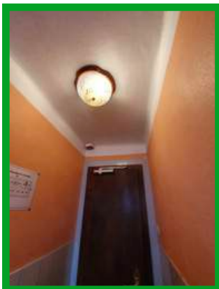
Remise en peinture d'un plafond (avant et après)
