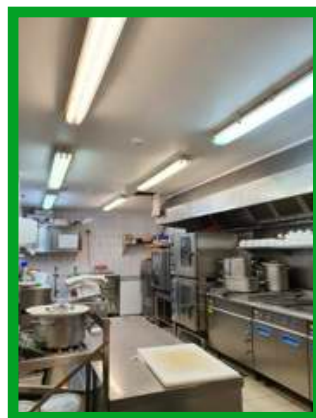
Renforcement de l'éclairage dans la cuisine.
